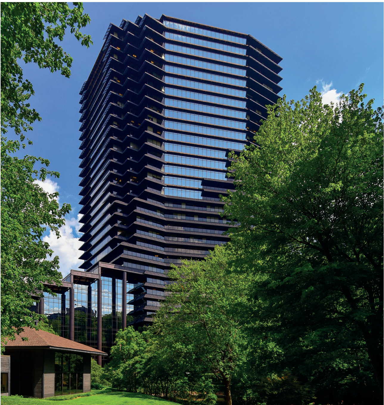
Der weithin sichtbare Bürotower wird in Atlanta von vielen als Landmark-Immobilie wahrgenommen
