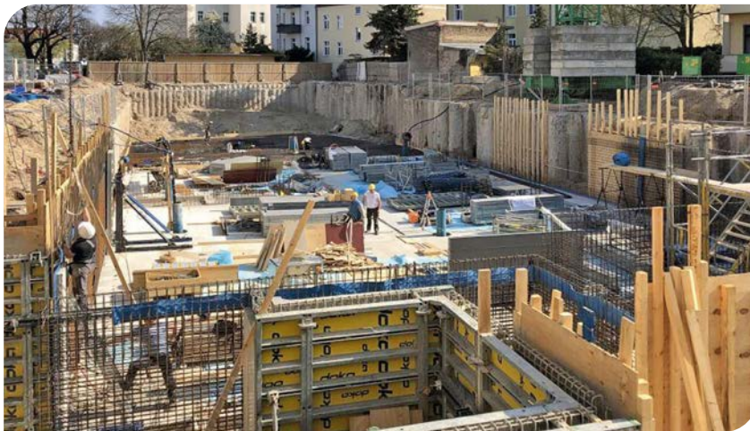
Trotz Corona-Shutdown: Die Bauarbeiten gehen bei PROJECT wie in der Hönower Straße in Berlin weiter
